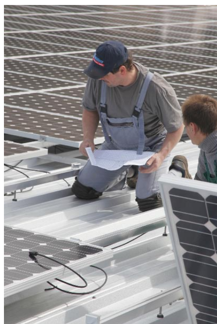
Zwischen den Modulen und der Dachhaut sollte mindestens zehn Zentimeter Platz gelassen werden.
