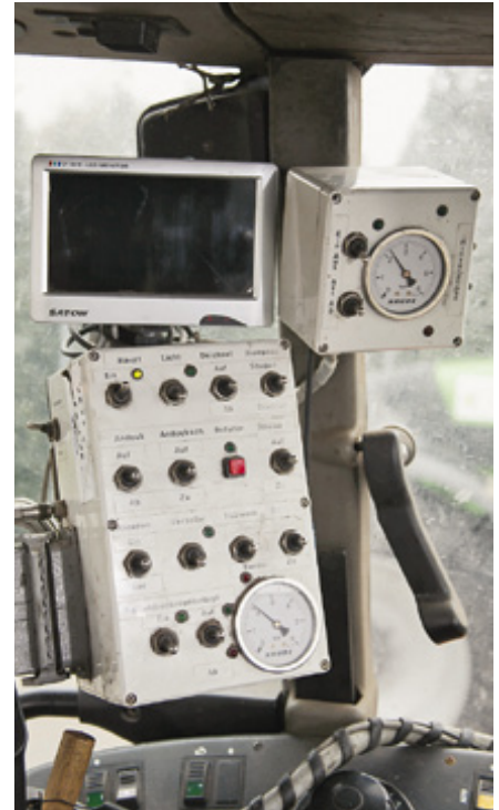
Elektrische Steuerungen arbeiten h ufig ohne Monitor. Die Funktionen schaltet man per Kippswitcher.
