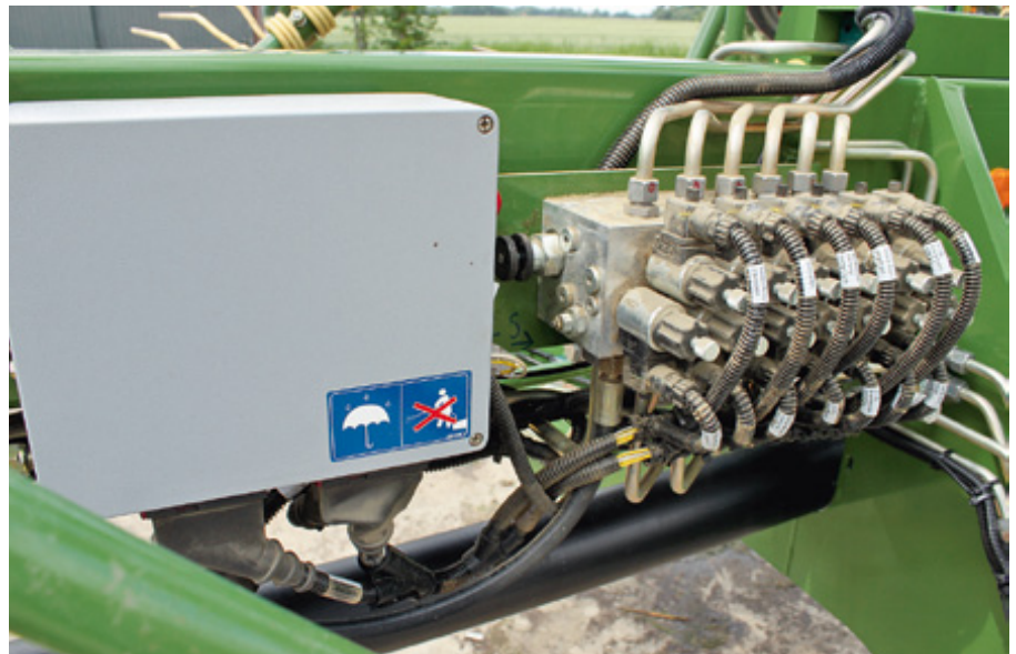
In dem grauen Kasten verbirgt sich der Jobrechner einer elektronischen Steuerung. Er steuert die Funktionen elektronisch per CAN-BUS.
