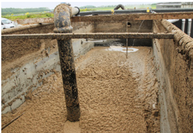
Der Rübenbrei gelangt von der Lagune erst einmal in einen Zwischenspeicher mit 40 m 3 , in dem er angewärmt wird.
