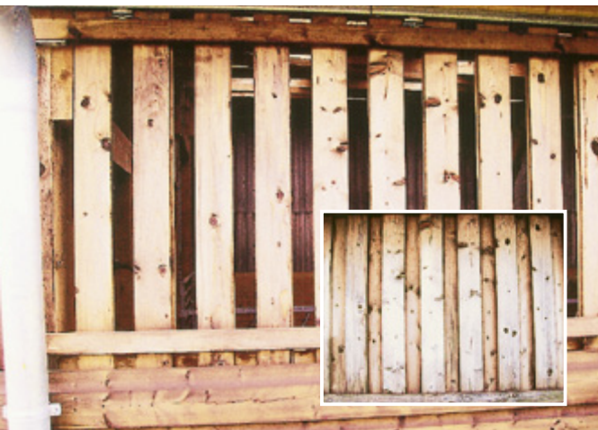
Das variable Spaceboard hängt in einer Helm-Schiene. Mit einer Kurbel wird es hin- und hergeschoben.
