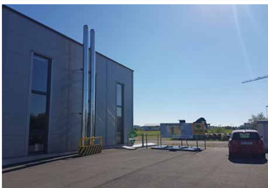
Betriebsgebiet Haag: Unterflur-Biomasseanlage mit 2 x 150 kW
