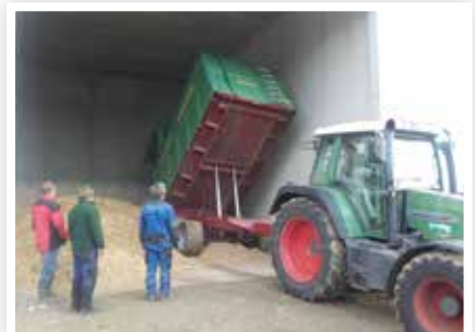
Erstbefüllung einer 500-kW-Anlage zur Wärmeversorgung einer Bildungseinrichtung
