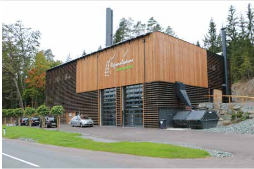
Gute Wärme kommt aus der Region: das Heizwerk Krumpendorf
