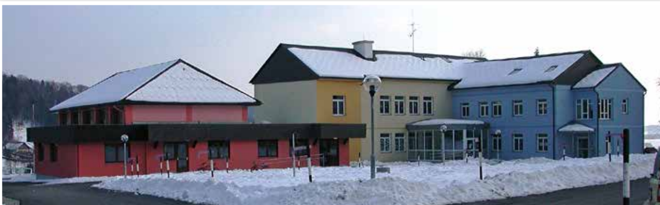
Das Ortszentrum von Empersdorf/Südsteiermark: Vier örtliche Landwirte versorgen mit Waldhackgut das Gemeindezentrum – mit 160 kW Leistung.
