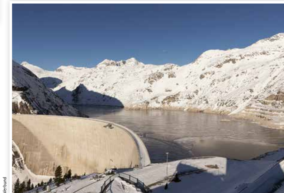
Das Pumpspeicherkraftwerk Malta Oberstufe ist das zweitgrößte Wasserkraftwerk Kärntens – insgesamt liefert die Wasserkraft in Kärnten über 90 % der Stromerzeugung.
