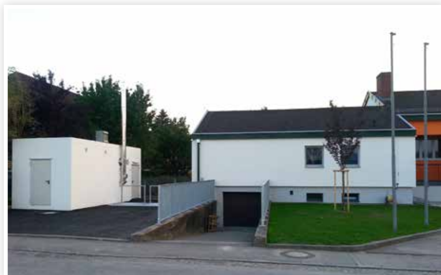
Groß-Siering: Containerlösung der Bioenergie NÖ für die sanierte Volksschule des Ortes
