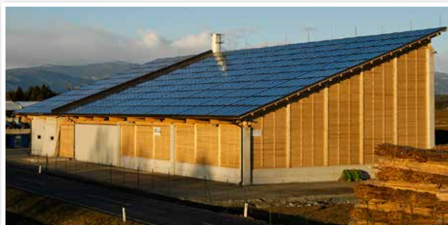
Thermische Solaranlage Gleinstätten
