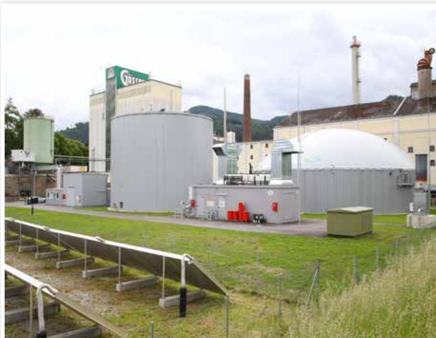
Das Gelände der Brauerei mit Solarkollektoren und Biotreibervergärungsanlage
