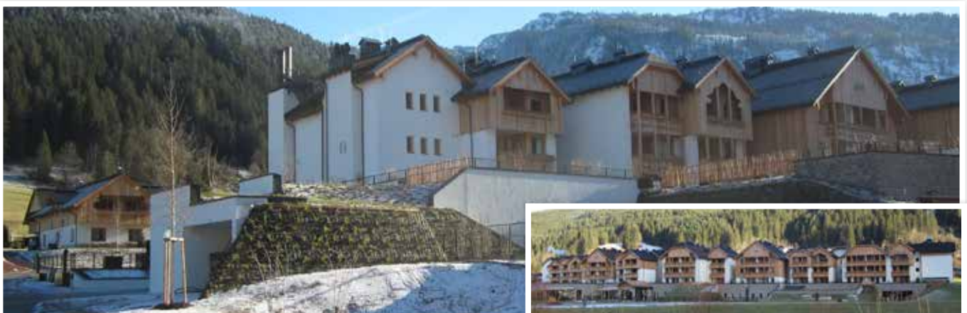
Das im Dezember 2016 eröffnete Leading Family Hotel & Resort Dachsteinkönig in Gosau wird per Wärme-Contracting von einer 1.000-kW-Pelletsanlage versorgt.
