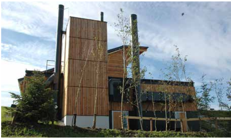
Heizwerk Mattsee im Flachgau – in ganz Salzburg gibt es 100 Biomasse-Heizwerke mit einer Gesamtleistung von etwa 230 MW.
