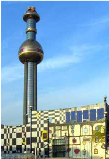
Die Müllverbrennungsanlage Spittelau macht aus jährlich 250.000 Tonnen Hausmüll Wärme und Strom.
