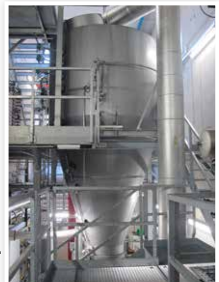
Schwebbett-Reaktor im Heizkraftwerk
