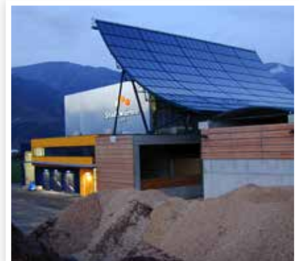
Biomasse-Fernheizkraftwerk Lienz – ein EU-Demonstrationsprojekt
