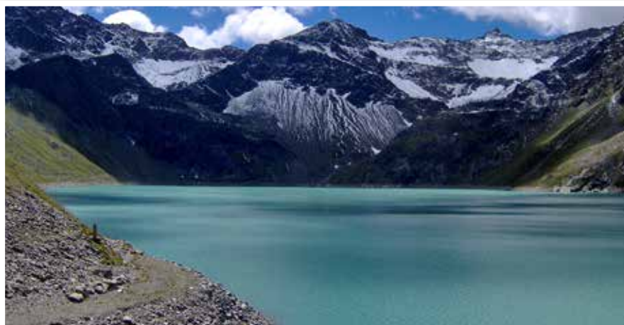
Der Speichersee Finstertal bei Kühltal liegt auf einer Meereshöhe von 2.300 m und dient als Wasserreservoir der großen Tiroler Speicherkraftwerke Silz und Kühltal.
