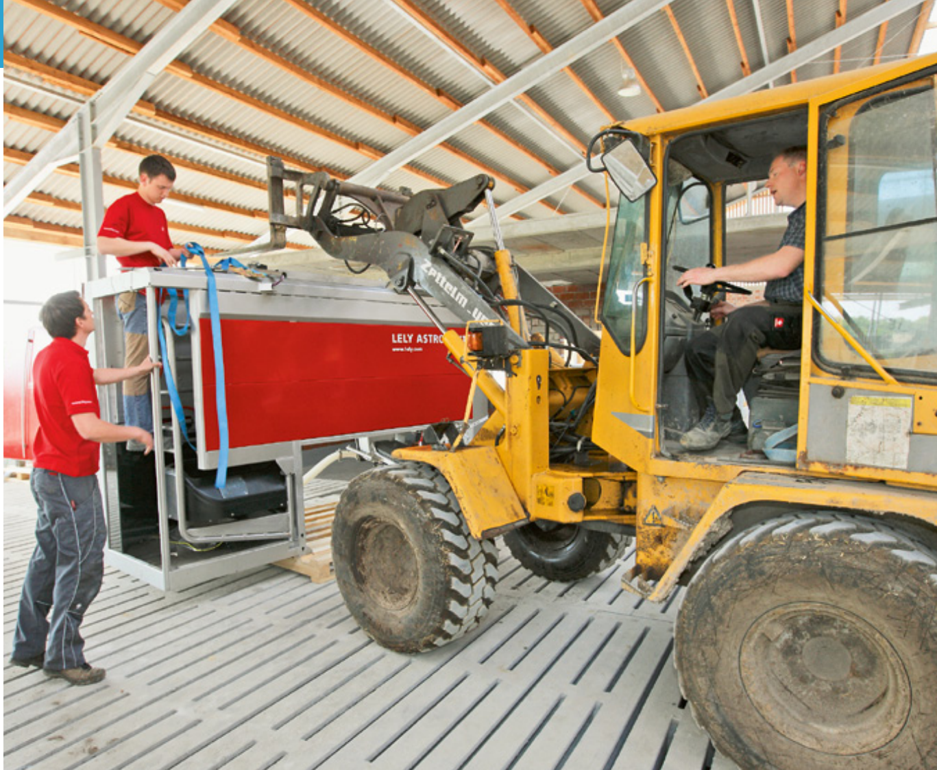
Montage eines Melkroboters in einen Neubau: Bereits bei der Bauplanung müssen Sie die besonderen Anforderungen der Melkroboter beachten.
