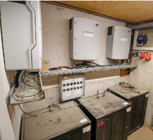
△ Die drei Batteriemodule im Betrieb Posch haben je 15 kWh Speicherkapazität.
